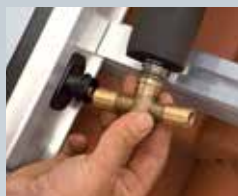
Emboîter les deux raccords en T
