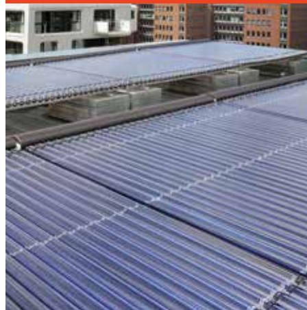
Fig. 3.4 Capteurs à tubes sous vide horizontaux
