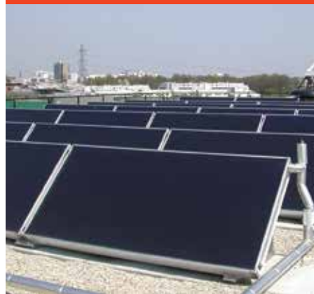
Fig. 3.3 Capteurs plans montés sur support
